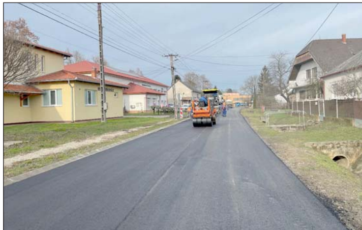
Az elmúlt időszakban több fontos útfelújítás történt.
