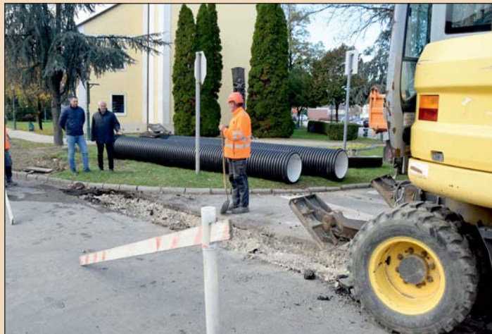
A templom környékén is végzik a vezeték cseréjét, a csapadékvíz-elvezető rendszer felújítását.
