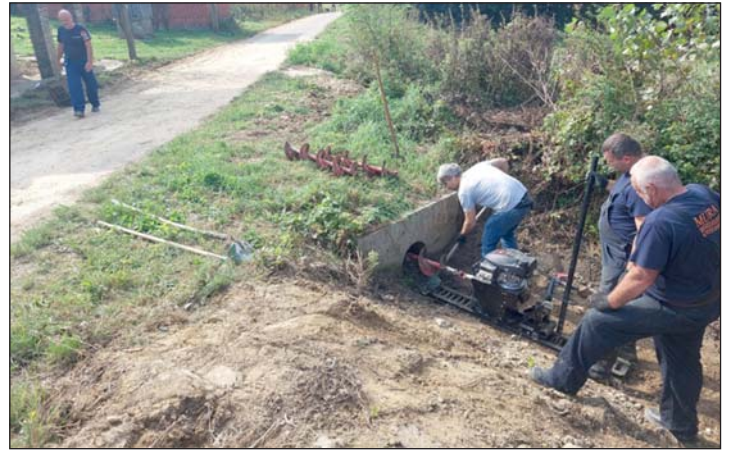
Vízvezető átereszek tisztítása a János-hegyi (gyótai) zártkerteknél.
