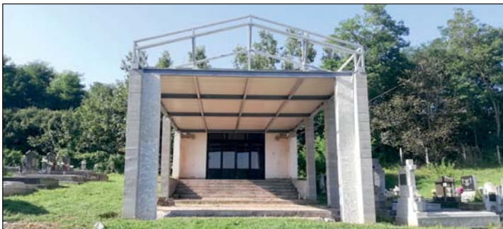
Felújítás alatt a zalapataki temető ravatalozója.
